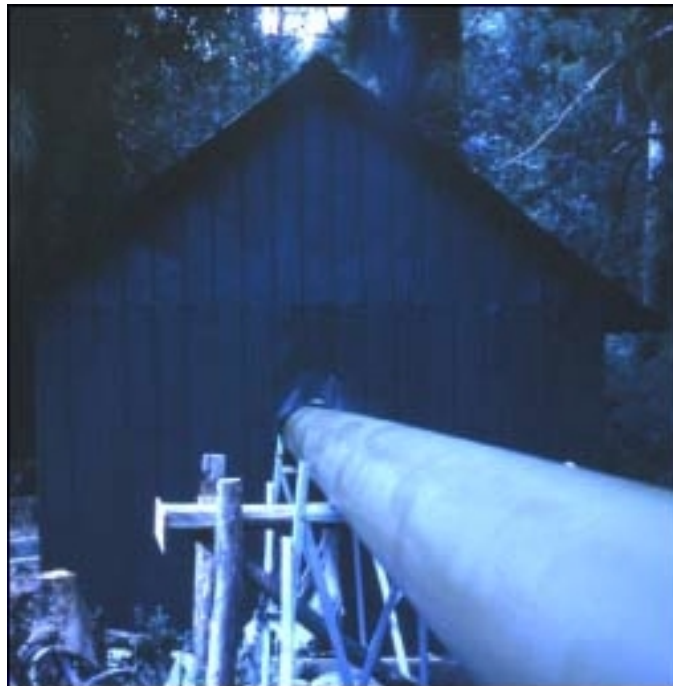
Foto 11. Vista exterior de la casa de turbina para la obtención de energía eléctrica para Caleta Gonzalo.
