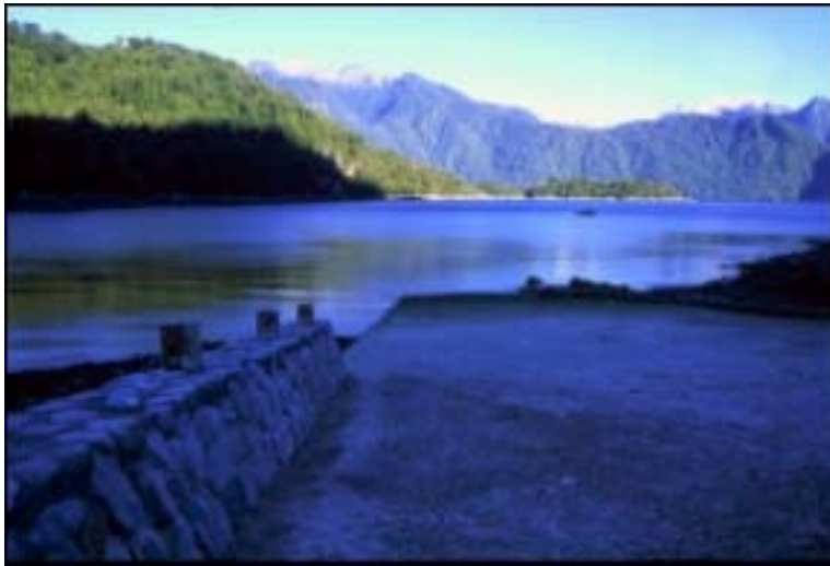
Foto 52. Vista parcial de la rampa de Fiordo Largo.
