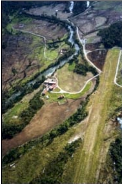
Foto 35. Vista aérea sector residencial, junto al Río Trolihuán.
